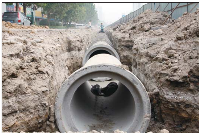
东风街地面已经开挖,新的雨水管道正在铺设。 本报记者 孙国祥 摄
