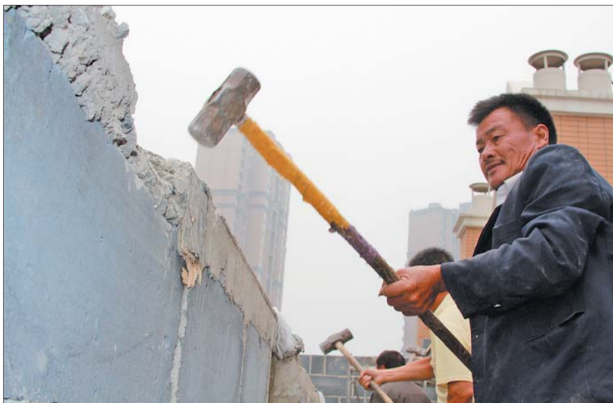
工人在对违建阳台外墙进行拆除。 见习记者 王富军 摄
