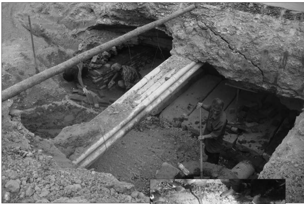
▲工作人员对暗坑进行修复。
