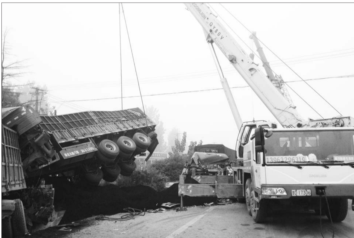
救援人员使用救援机械拉开空间将被困人员救出。 本报通讯员 杨艺 摄
