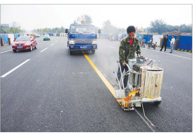
21日,三八路岔河桥开放通行,按滨河东路的修建计划,23日将对东方红路岔河桥进行封闭施工。 图为22日,施工人员正在三八路岔河桥施划道路标线。 本报记者 马志勇 摄
