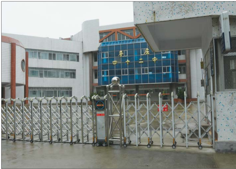
23日下午,枣庄四十二中大门紧闭。本报记者 马明 摄
