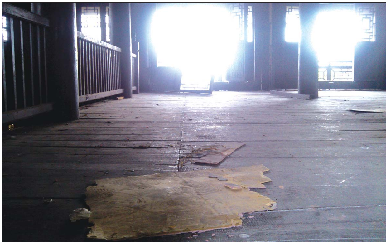
几块拆下来的门窗乱堆在建筑内。本报记者 邵艺谋 摄
