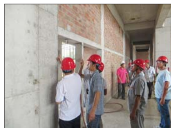
功能结构实体现场交流
