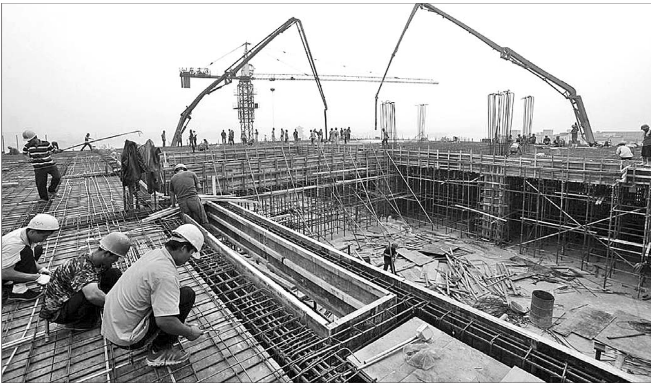
23日,施工人员正实施封顶作业。 本报记者 孟凡萧 通讯员 程兴普 摄
