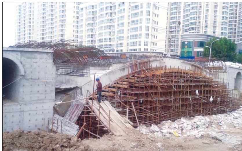
越河桥主拱已经完成,腹拱已经搭起了钢筋支架。本报记者 公素云 摄
