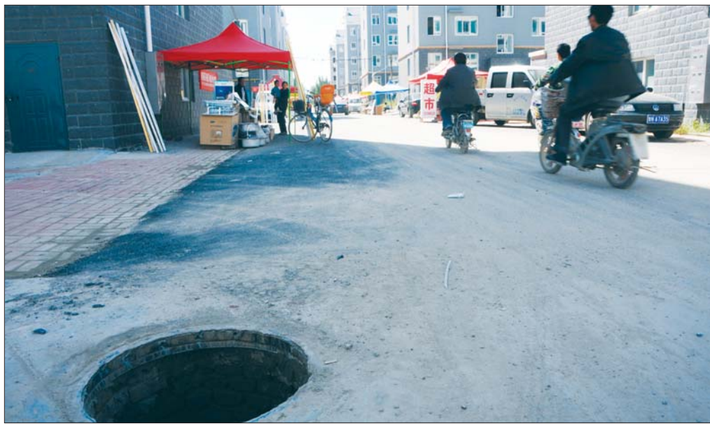
翟时苑社区内井盖等基础设施尚未到位。 本报记者 马志勇 摄
