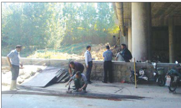
施工人员维修污水管道,图为工人在轧钢筋。本报记者 陈新 摄
