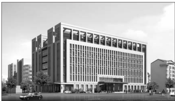
门诊医技综合楼
