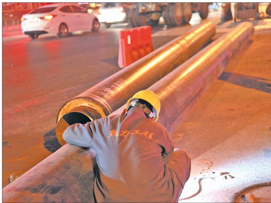
热力公司工作人员深夜正在东关大街加紧施工。
