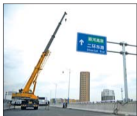
北园高架延长线正在安装路灯。
