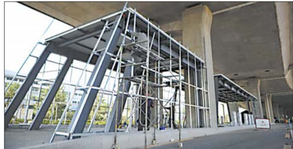
二环西路BRT站台预计10月底可完工。
