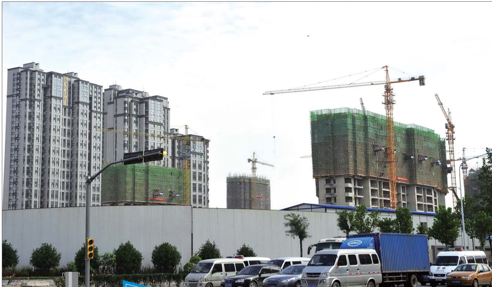
二环西路高架旁边有不少在建楼房。
