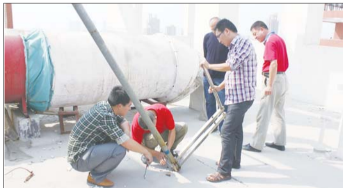
技术人员拆除黑电台天线。
