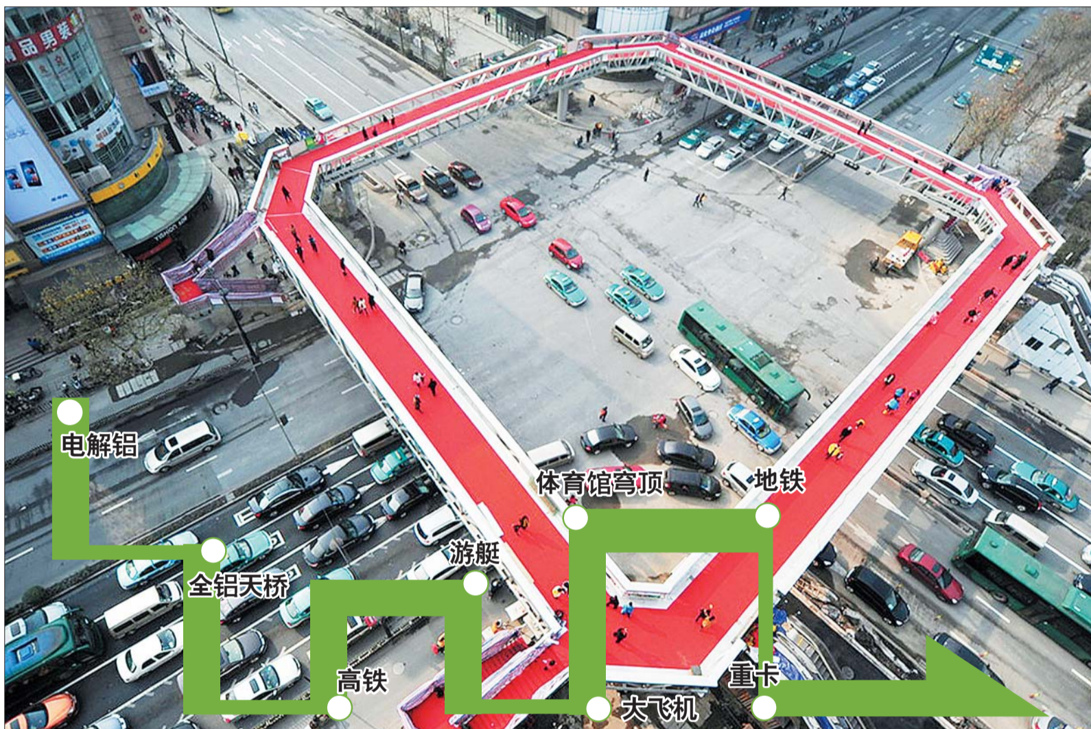
图为丛林集团承建的杭州解百天桥。
