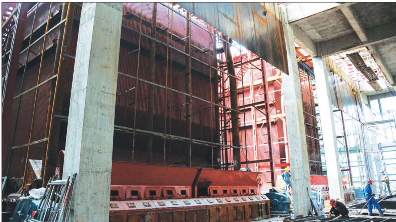
两台锅炉主体已经于上月初安装完毕,辅机将于10月底装好。图为施工现场。 本报记者 韩逸 摄
