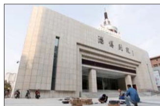
淄博剧院外,工人正在进行最后的施工。 本报记者 王鑫 摄
