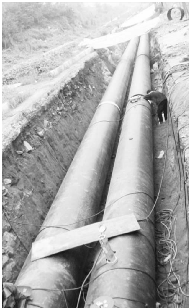
为确保供热,热力部门提前进行管网建设。(资料片)
