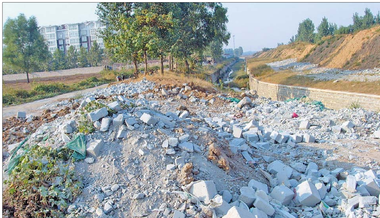
奥体中路与工业北路交界处西北角, 河道沿岸的建筑垃圾逼近泄洪河道。 本报见习记者 王富军 任丽媛 摄
