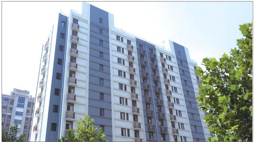
已经完工的沁园新居。 本报见习记者 郭凯 摄
