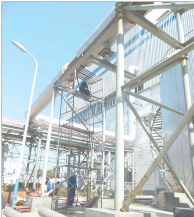
黄台电厂工人正在修建中心换热站。 本报记者 蒋龙龙 摄
