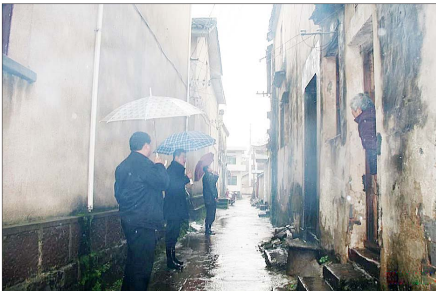
直管公房多为平房和简易楼,房屋现状和居住环境较差(资料片)。
