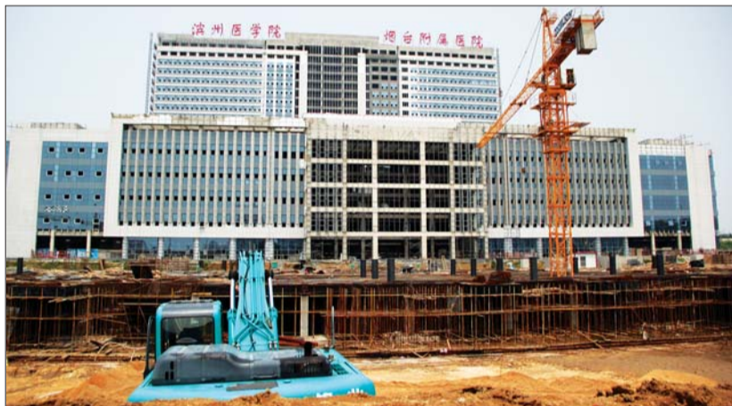
滨医烟台附院大楼正在施工,预计明年5月投入使用。本报记者 韩逸 摄
