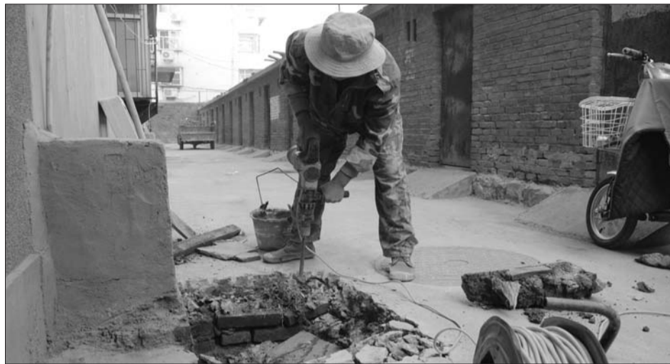
▲工作人员正在紧张安装新井盖。 本报记者 姜文洁 摄
