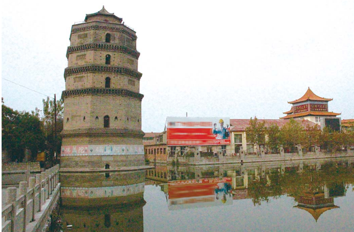
已逾千年,永丰塔依然气势雄伟,大气磅礴。本报记者 李德领 摄
