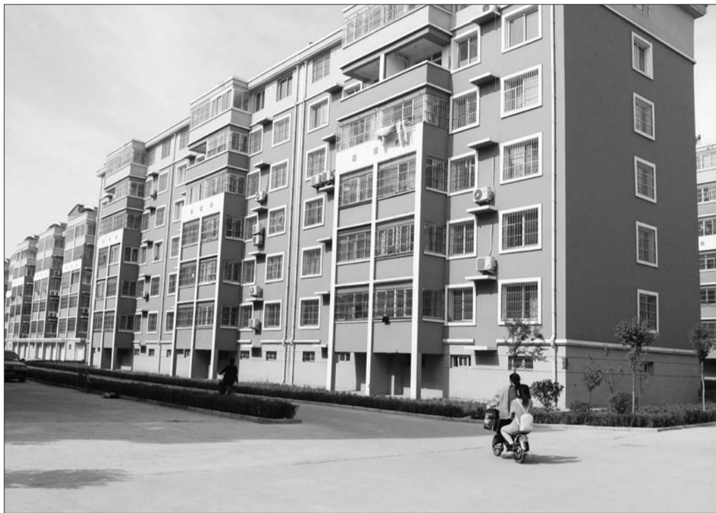
一排排新建的多层楼却没有楼牌号。 本报记者 李婷婷 摄
