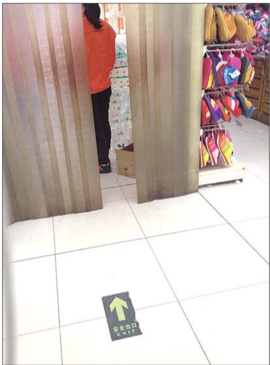
一超市消防安全通道变成了仓库。
