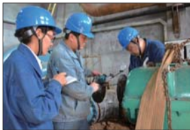
供暖季前,检修员工对设备进行检修维护。 通讯员 陈秀民 摄
