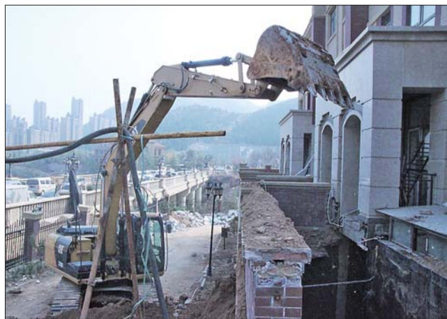
别墅墙体都裸露出来,推土机正在朝里面填土。见习记者 李文平 摄
