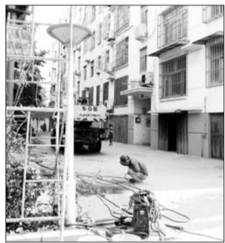
施工人员在中武新苑小区铺设供热管道。本报记者 公素云 摄
