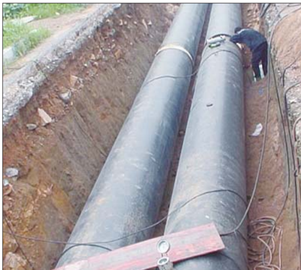
工作人员加快施工。(资料片)
