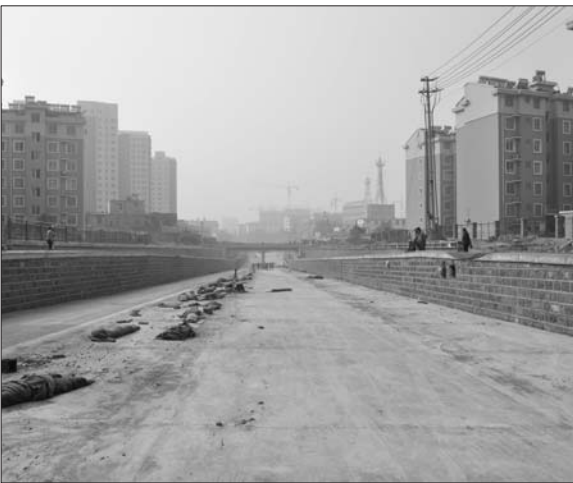
解放北路立交桥主干道混凝土浇注完成现场。 本报通讯员 曹建明 摄
