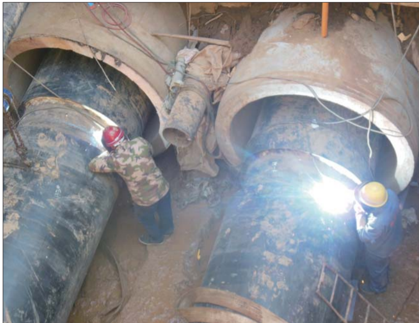
工业北路和坝王路附近,热力公司工人正在对供暖管道进行焊接。 本报记者 蒋龙龙 摄
