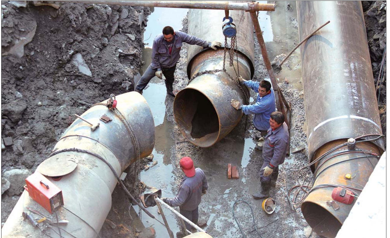
工业南路附近,热力公司正在施工。见习记者 张伊寒 摄
