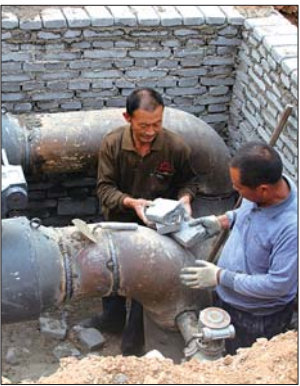
黄金时代小区,施工人员正在更换新管网。
