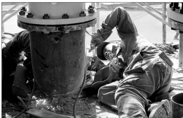
24日,工作人员正在城西换热站安装供热设备。 本报记者 李玉涛 摄
