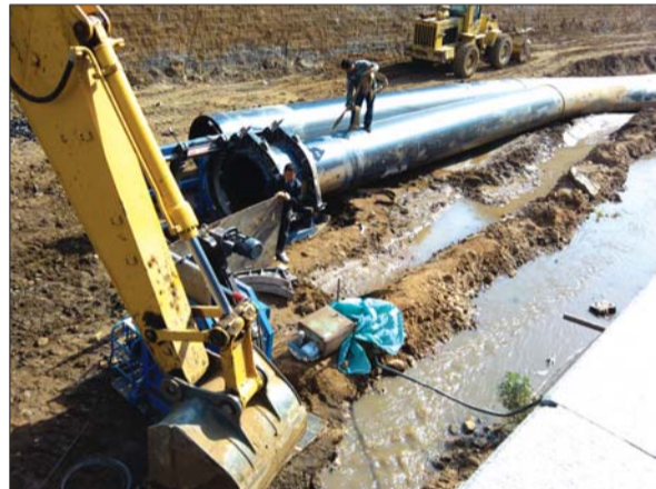
施工人员正铺设引水管道。本报记者 王世腾 摄 上唐庄拦蓄枢纽工程开工建设,目前主体工程已完工,这使得胜利渠引水规模达到15
