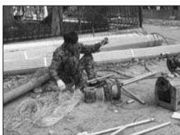
▲施工人员正在理顺管道。 本报记者 罗静 摄
