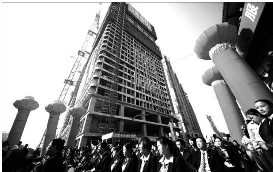
封顶的万达广场。本报记者 张晓科 摄
