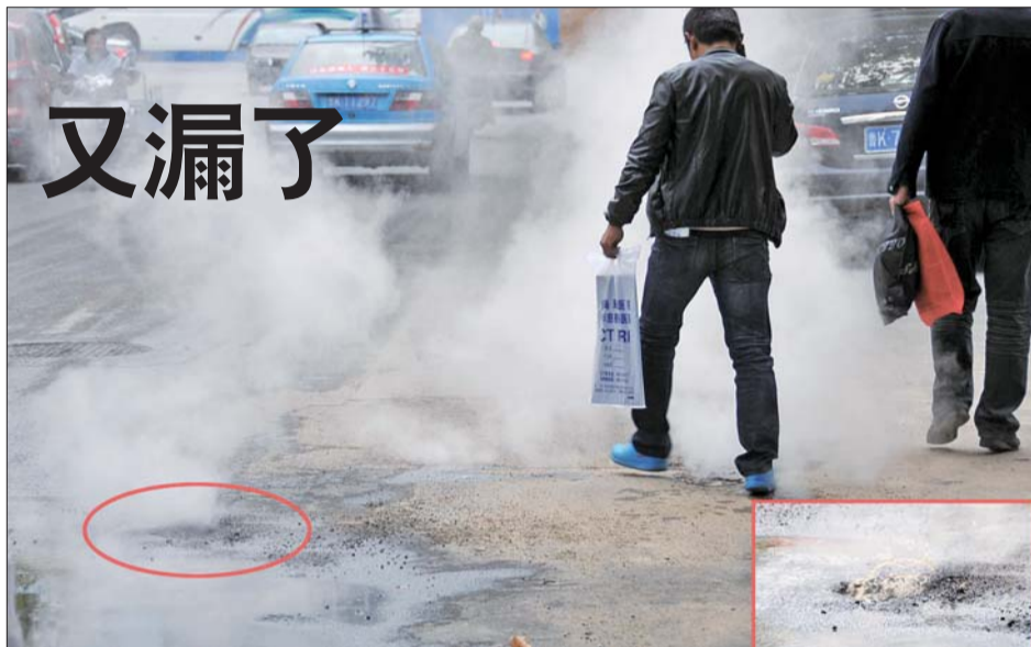
28日,在海港路中间,几处破裂的热力管道冒出了大量蒸汽,其中一条管道破裂较为严重,地面上直接有热水喷涌而出,路面有不少积水,很多市民在此经过,非常危险。据附近市民介绍,这个地方之前修理过,最近又出现了问题,每当下雨整条路都会冒热气。 本报记者 王震 摄影报道
