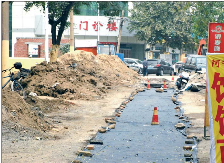
施工路段放上了警示墩,受损的助力车还放在沟旁。本报记者 路帅 摄
