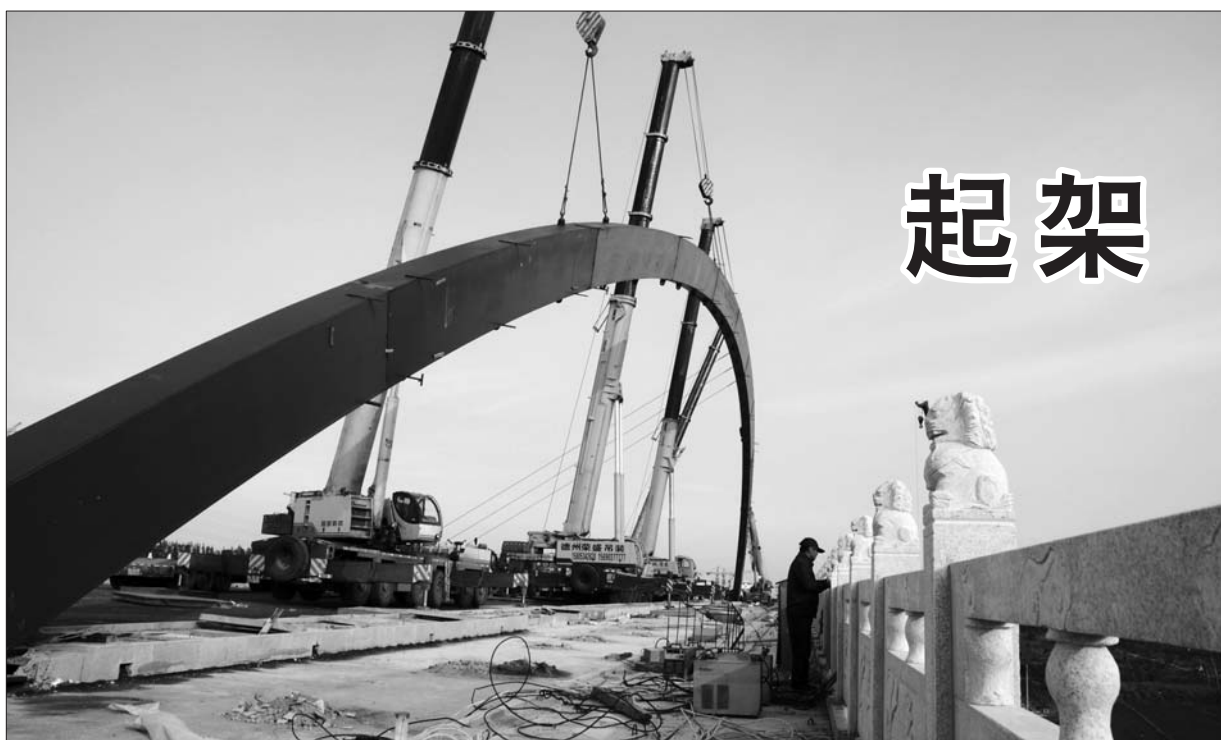
10月30日,天衢路减河桥上,施工人员正在起架钢制拱梁。 本报记者 马志勇 王乐伟 摄影报道
