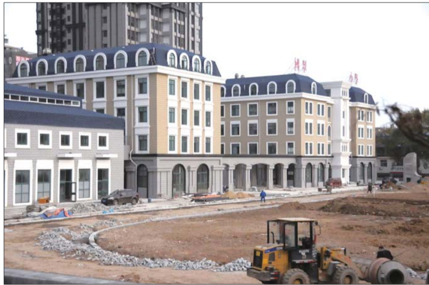
改扩建即将完工的国翠小学。本报记者 李泊静 摄
