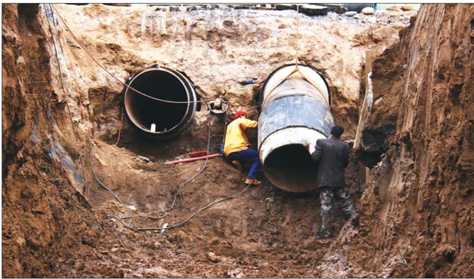
11月5日,在长河大道与天衢路交叉口不远处,施工人员正在对接供热管网,此路段是天衢路段上最后的管网铺设工程。 本报记者 王小会 摄
