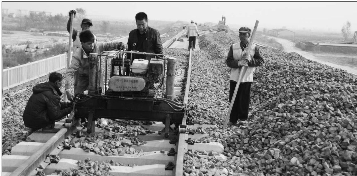
阳信县洋湖乡德大铁路滨州段铺轨现场。
