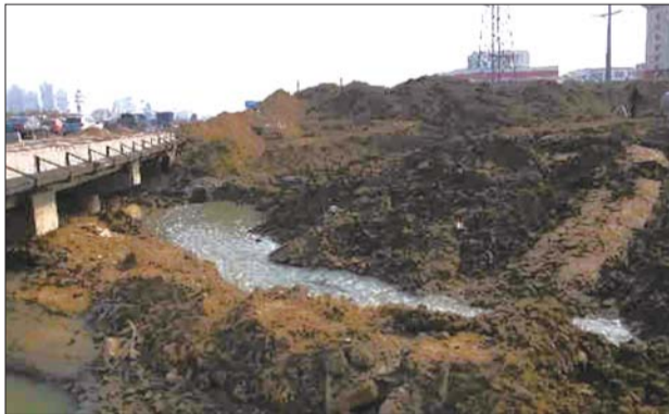
污水井口已被挖开,污水不再流入逛荡河了。本报记者 张倩倩 摄
