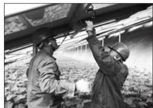
电力工人在安装并网设备。
